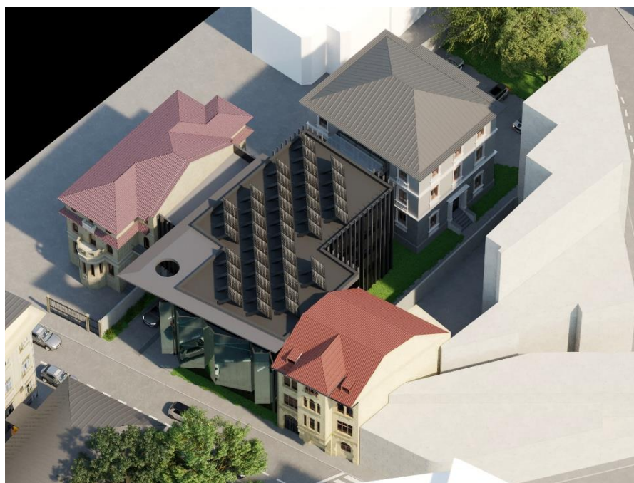
Figura 14. Panouri fotovoltaice montate pe acoperișul tip terasă
